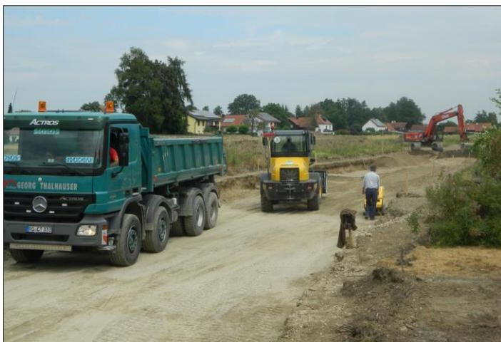
**Im Baugebiet Haiming-West haben die Arbeiten für die Erschließungsanlagen begonnen. Neben den Straßen- und Kanalbauarbeiten werden zu den 42 Bauparzellen Leitungen für Wasser, Strom, Glasfaser und Gas verlegt werden.**
