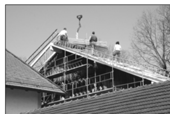
Rechtzeitig für die Theatersaison 2009 wurde das Dach des Theaterstadts erneuert.
