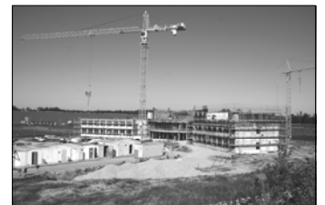
Großbaustelle im Industriegebiet: Das neue OMV-Verwaltungsgebäude
