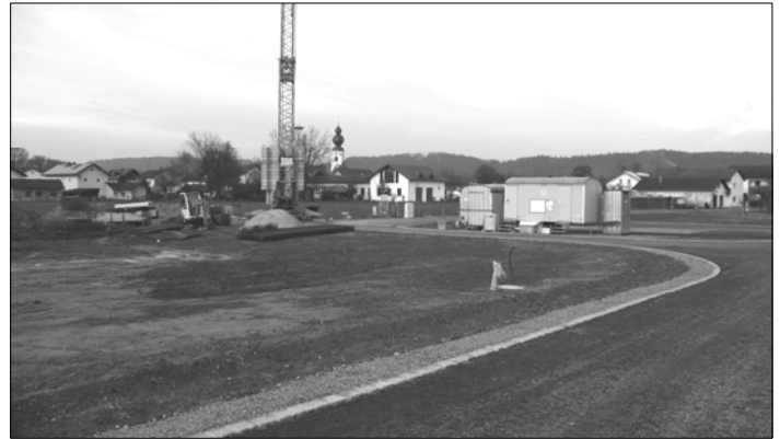
Die Erschließung des Baugebiets Wirtsfeld-Ost ist fertig.
