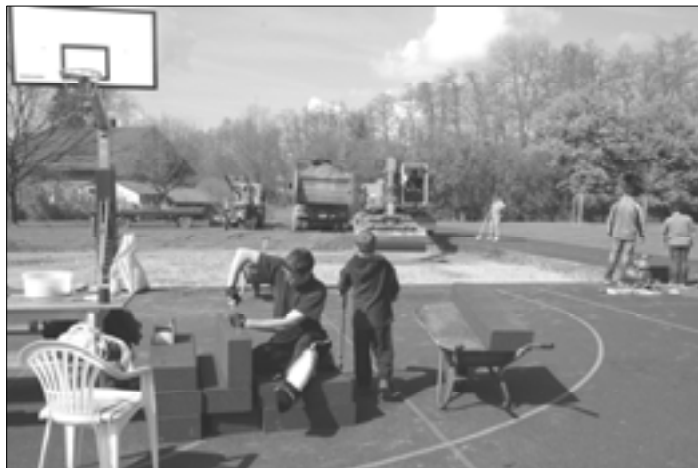
Start zum Bau des Beachvolleyballplatzes – am 3. Mai soll das Eröffnungsspiel stattfinden.
