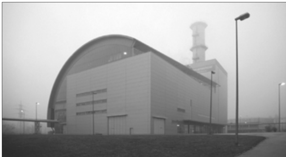
Einen Eindruck von Größe und auffälliger architektonischer Gestaltung bietet das GuD-Kraftwerk in Wien.
