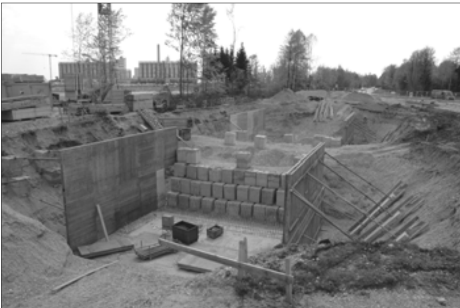
Die Bauarbeiten an der Unterführung der B 20 sind voll im Gang
