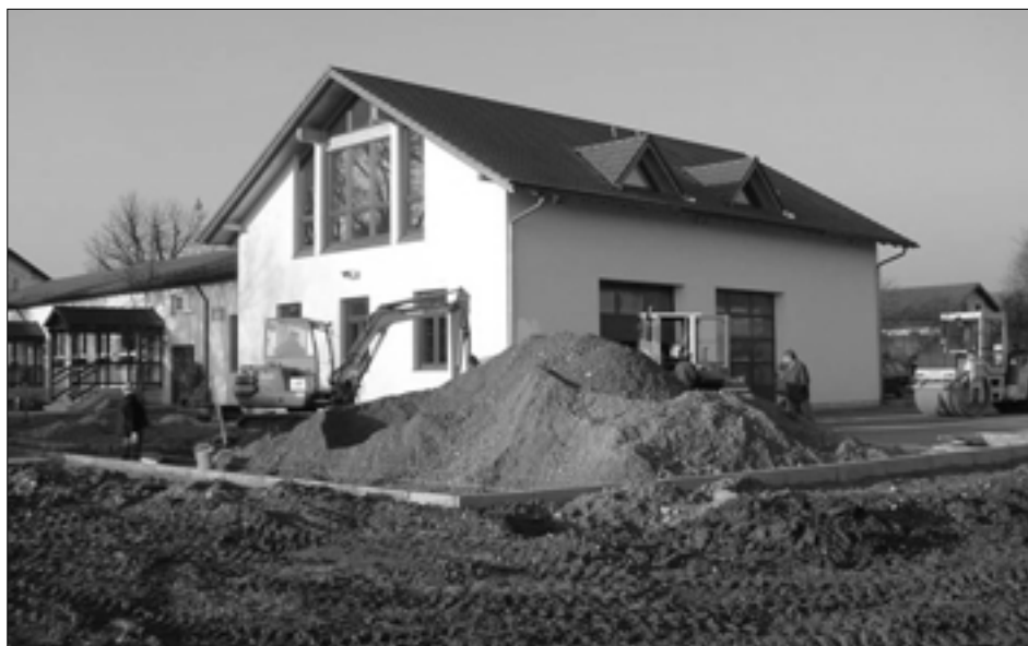
Eine herausragende Leistung des Jahres 2004 ist der Bau des Feuerwehrhauses Niedergottsau. Seit dem 1. Spatenstich am 16. April haben insgesamt 109 Fachleute und Helfer in 10.562 Stunden ehrenamtlicher Arbeit das Gebäude mit dem Turnraum für den Kindergarten errichtet. Bis auf einige Abschlussarbeiten ist das Bauwerk zum Jahresende fertig.
