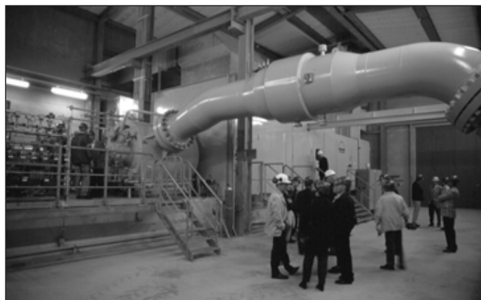
Kernstück der Anlage in Rückersdorf, Gasturbine in der Schallschutzkabine und Kompressor mit Gasdruckleitung
