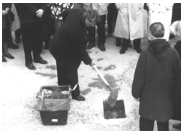
Ein Grundstein, am 30. Oktober dieses Jahres gelegt, wird weit in das 3. Jahrtausend hinein das neue Haiminger Altenheim tragen. Übrigens: die 3. Ausgabe der NIEDERGERNER wurde mit eingemauert.
