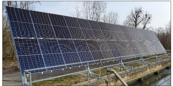
Zwei neue PV-Anlagen für den Eigenstromverbrauch: Auf dem Rathaus 12,5 kWp und einem Stromspeicher mit 10,0 kW und in der Kläranlage 13,0 kWp. Mangels Netzzugänglichkeit kann in der Kläranlage derzeit keine größere Anlage gebaut werden.
