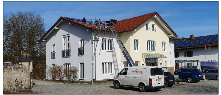
Zwei neue PV-Anlagen für den Eigenstromverbrauch: Auf dem Rathaus 12,5 kWp und einem Stromspeicher mit 10,0 kW und in der Kläranlage 13,0 kWp. Mangels Netzzugänglichkeit kann in der Kläranlage derzeit keine größere Anlage gebaut werden.
