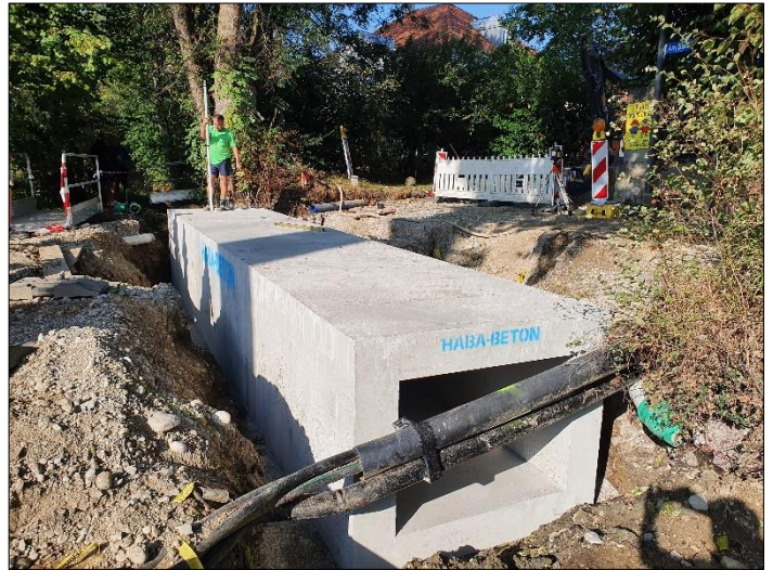
Ein mächtiger Betonklotz ist der neue Durchlass für den Haiminger Mühlbach an der Fahnbacherstraße. Mittlerweile ist alles verfüllt und der Bach läuft wieder.
