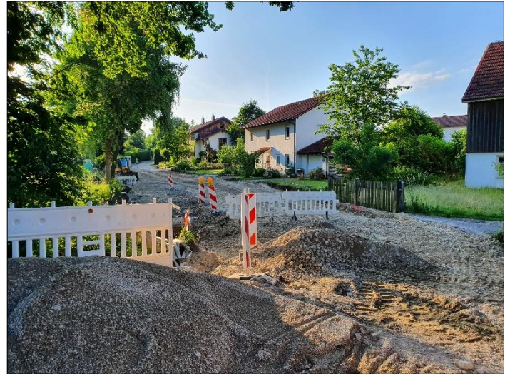
Derzeit die größte Baustelle in Haiming: Die Sanierung der Fahnbacher Straße und der Ausbau des Birkenweges. Die Anlieger brauchen viel Geduld, bis im Herbst alles fertig ist.
