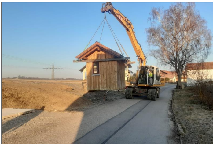
Auch ein Bushäuschen will mal auf Reisen gehen – das Bushäuschen in Holzhausen wird versetzt.
