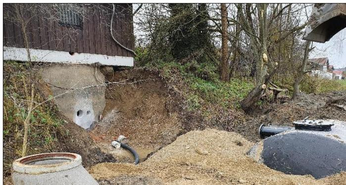
**Der Erdtank, der an die Pumpstation in Niedergottsau angeschlossen wird, dient als Sicherheit für den Abwasserkanal.**
