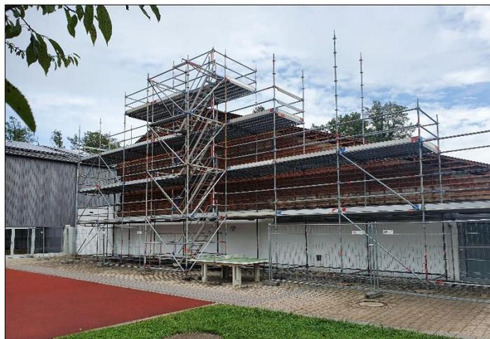
**Fast schon eine „ewige“ Baustelle: Die Westwand der Schulturnhalle. Die marode Plattenverkleidung ist entfernt, jetzt muss die Ziegelmauer verputzt werden. Aber bei allen Baufirmen gibt es bei solchen Kleinbaustellen Zeitverzögerungen.**
