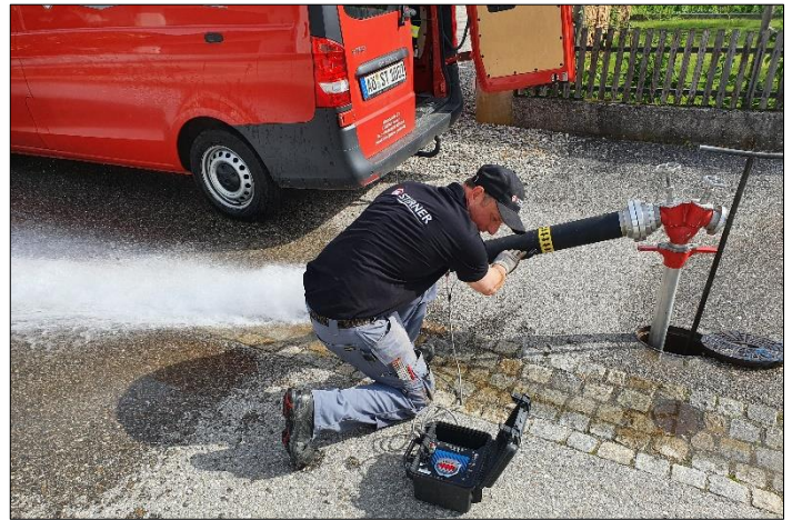
Eine besondere Aktion gab es in Niedergottsau: An 17 Hydranten wurde die Wassermenge gemessen, die im Ernstfall zum Löschen bereit steht. Das Ergebnis erfüllt die Vorgaben.
