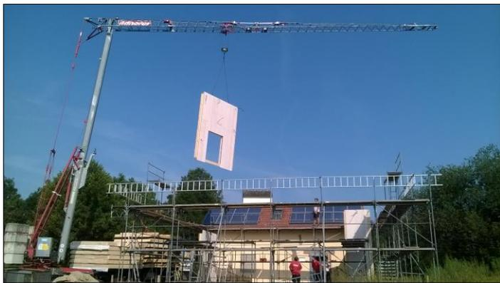
Fast wie vom Himmel herab schweben Wand-, Decken- und Dachteile für das neue Feuerwehrhaus Piesing ein und werden innerhalb eines Tages zum fertigen Rohgebäude zusammengefügt. An einem weiteren Tag haben dann die Piesinger Feuerwehrleute in Eigenleistung das Dach eingedeckt. In den zurückliegenden Wochen hatten sie in der Zimmerei Edhofer in Bergham viele Stunden in die Vormontage der Wandelemente eingebracht.
