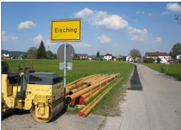
Die Fortsetzung des Gasleitungsbaus hat Eisching erreicht.
