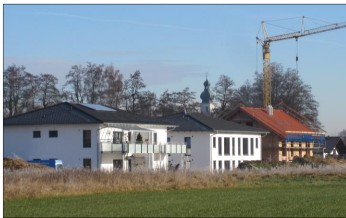
Die ersten Gebäude an der Erlenstraße sind schon fertig.
