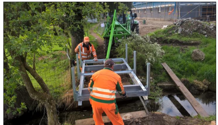
Die neue Brücke über den Haiminger Mühlbach – die erste Aktion bei der Neugestaltung der Außenanlagen
